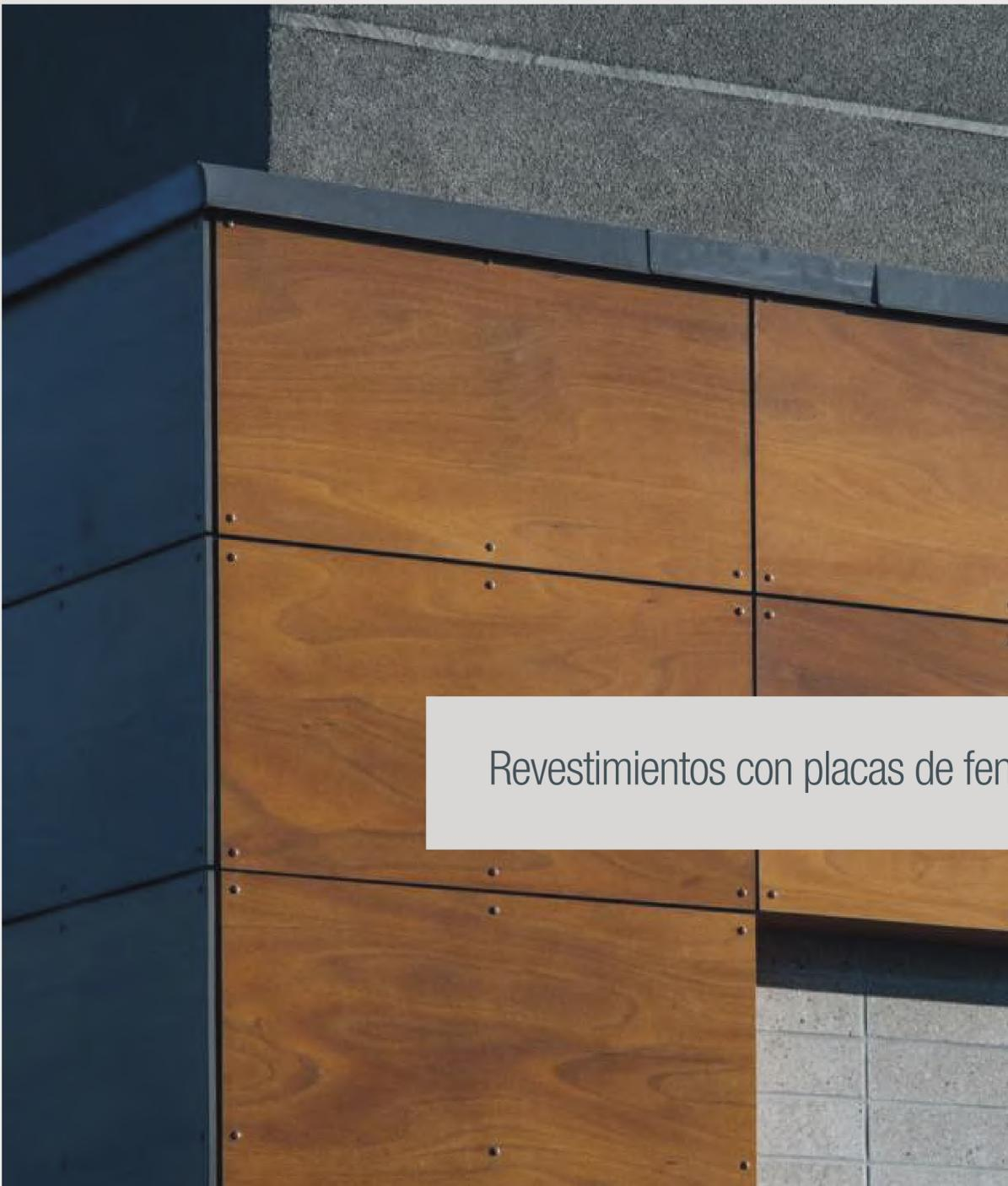
Revestimientos con placas de fenólico estructural
