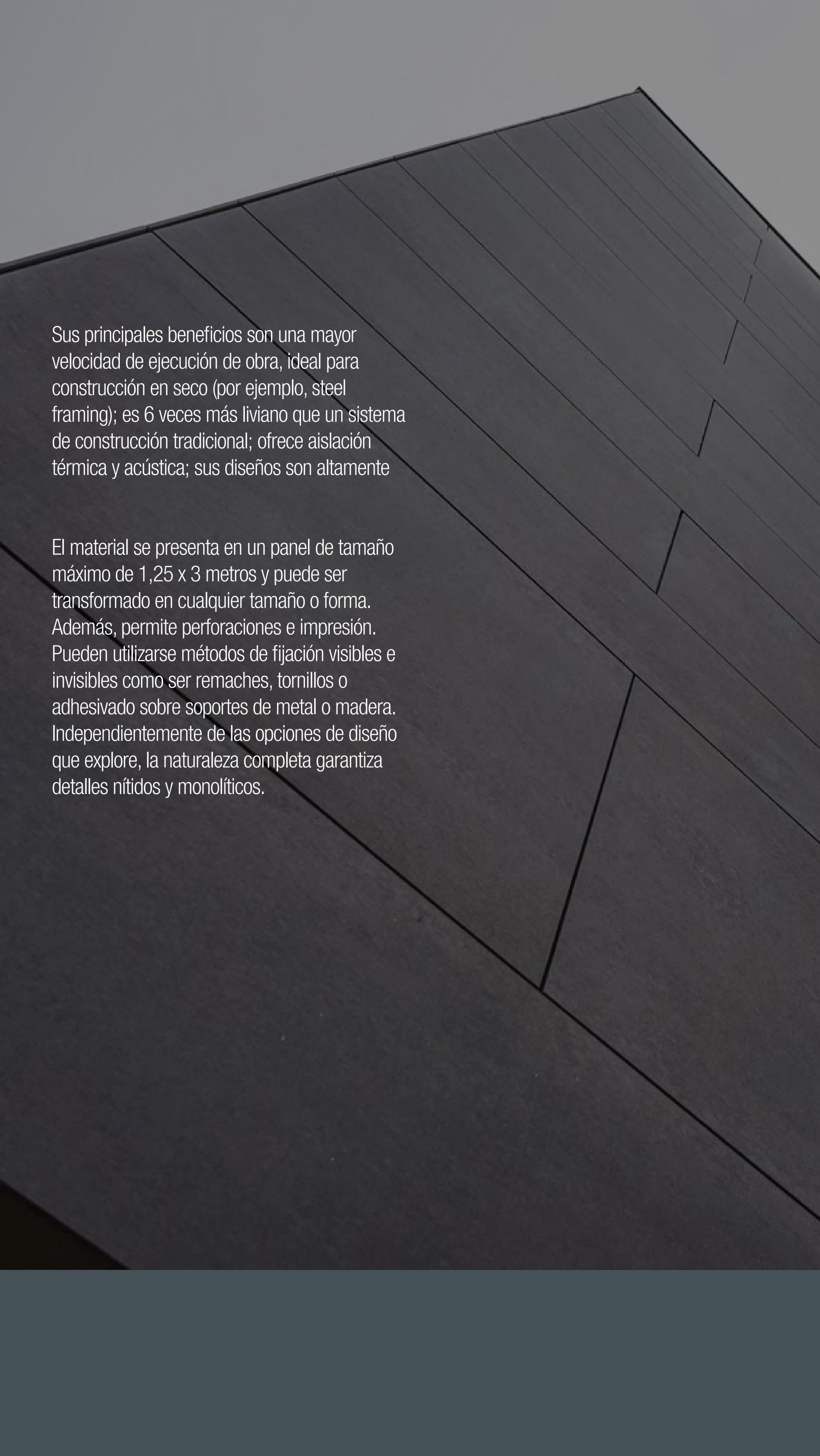
Sus principales beneficios son una mayor velocidad de ejecución de obra, ideal para construcción en seco (por ejemplo, steel framing); es 6 veces más liviano que un sistema de construcción tradicional; ofrece aislación térmica y acústica; sus diseños son altamente
