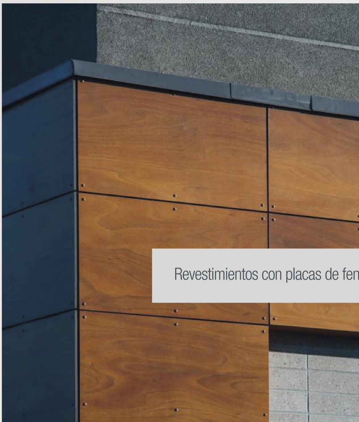
Revestimientos con placas de fenólico estructural
